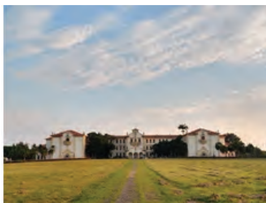
Figura 2 – Prédio Principal da UFRRJ – P1 Fonte: Própria, 2020.
